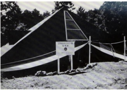
愛鷹山キャンプ場管理棟
