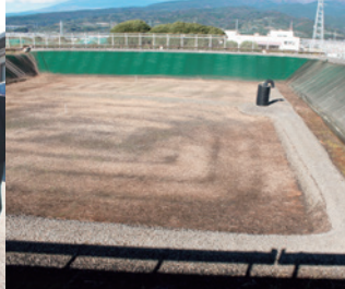
▲埋め立て用設備
